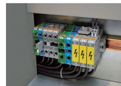
A fiação de entrada lateral significa que condutores ainda maiores, com flexibilidade limitada, podem ser facilmente conectados.
