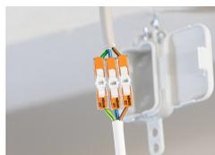
Conexão de iluminação em tetos suspensos
